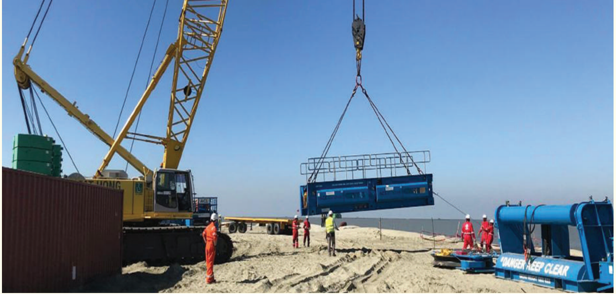
এলএনজি টার্মিনাল স্থাপনের কাজ চলছে।
